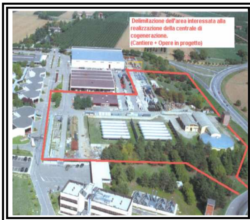
Foto aerea fornita da HERA in sede di V.I.A nel 2003 , ove sono riportati i 12 serbatoi di accumulo gas
