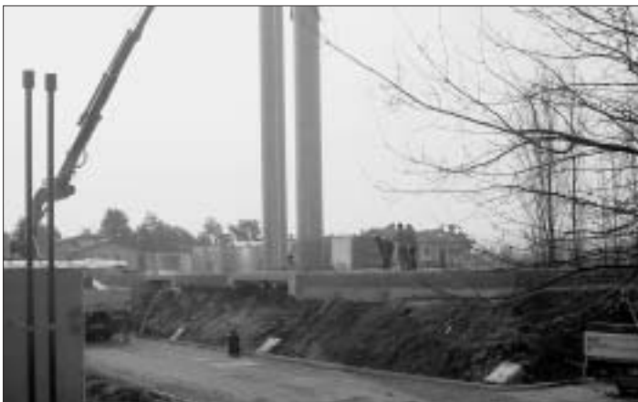
La nuova centrale costruita da Hera nell'area di via Donati
